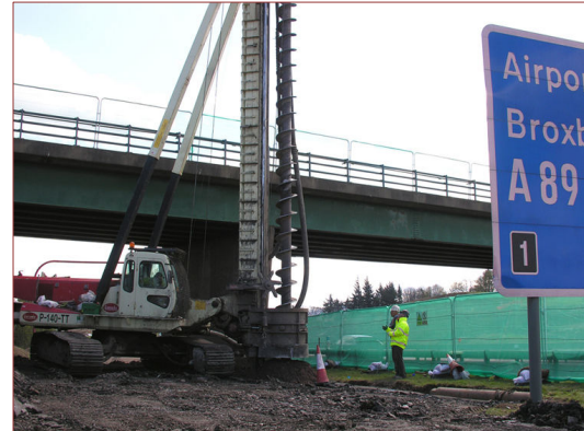
The P-140-TT Llamada CFA Rig
